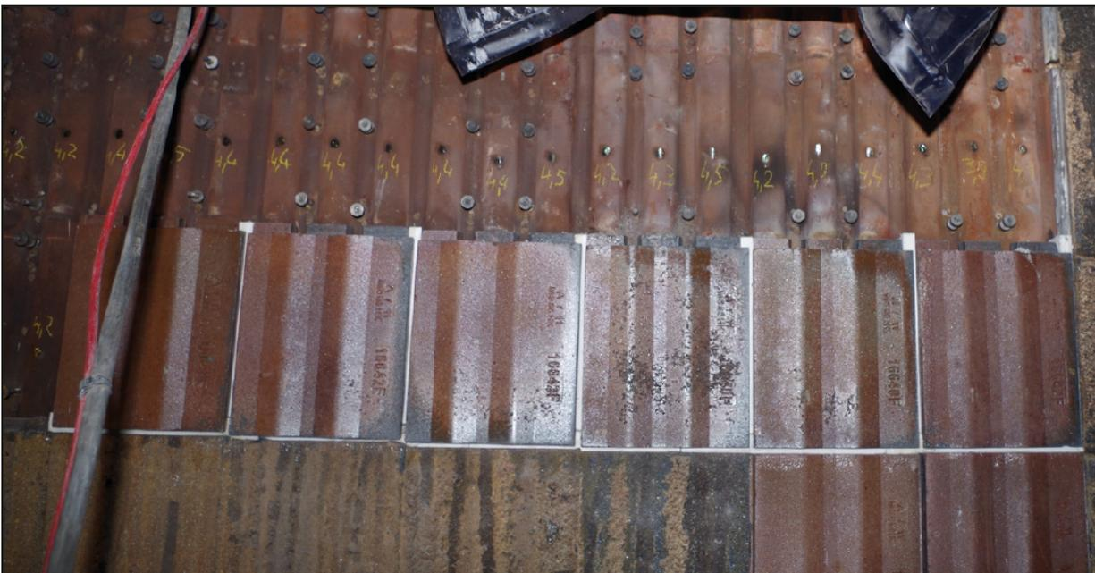
*Bild 5: Rohrwand nach Ausbruch der Plattenzustellung im Bereich der hinterlüfteten Platten. Die ermittelten Wanddicken vor und nach der ersten Betriebsphase mit hinterlüfteten Platten zeigen, dass keine weitere korrosive Abzehrung der Rohrwand stattgefunden hat*
