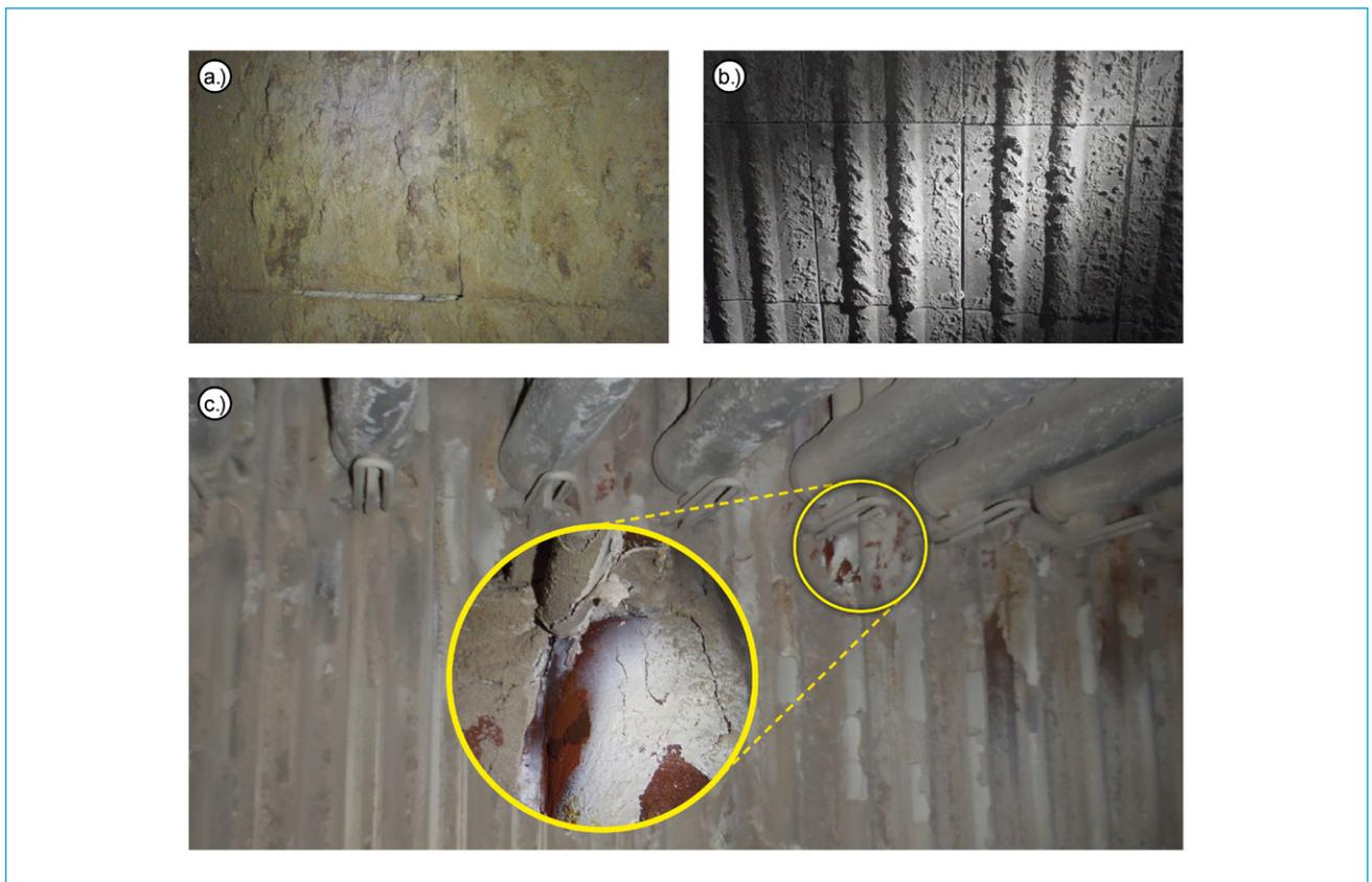
**Bild 18:** SNCR-Schlupf in einem Abfall-Heizkraftwerk. a und b: Fotos aus zwei Verbrennungslinien, gleiche Höhe, Rückwand des 1. Zug: Wechten wachsen von oben her auf und belegen eine Rückströmung, die auch die Höhe der SNCR-Eindüsen erfasst. c: Deliqueszenz-Korrosion durch Ammoniumchlorid an Kältefallen (Seitenwände im Bereich des ECO).
