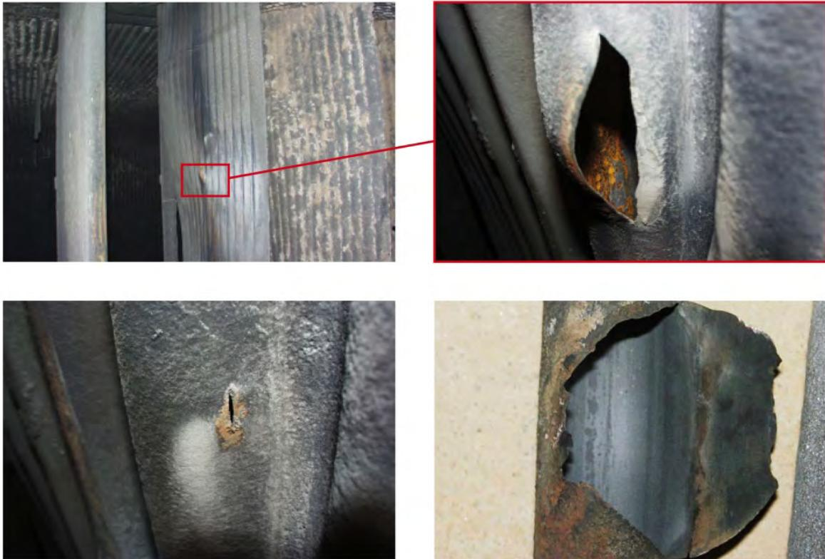
*Bild 23: Undichten und Rohrreißer*
