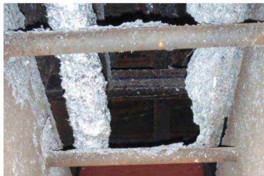
*Bild 30: Beeinträchtigung der Feuerung durch niedrigschmelzende Bestandteile von Brennstoffen*
