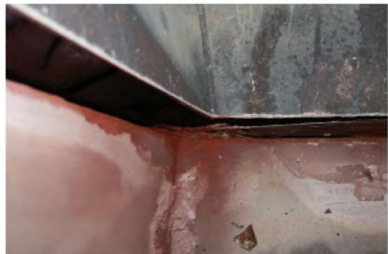
*Bild 22: Taupunktkorrosion (Rauchgasreinigung)*
