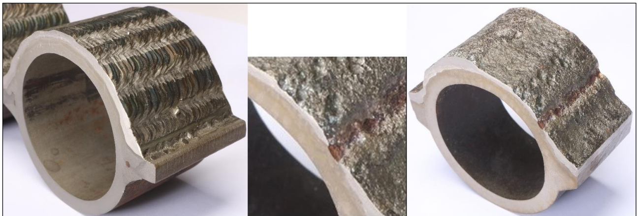
Abbildung 1: Eine feuerraumseitig schweißplattierte Wärmetauscher-Rohrwand (links „neu“) erfährt durch Salzschnmelzen und Hochtemperaturchlorkorrosion eine Abzehrung, hier lokal bis zum Grundwerkstoff an der Überlappungszone zweier Schweißraupen (rechts „alt“). Die bedingenden Faktoren sind: chemisches Reservoir im aufliegenden Salz-Asche-Belag, unterschiedliche Wärmestromdichte im Belag, primär differente Gefügeausprägung.
